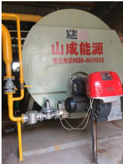
F2 供热锅炉技术改造
